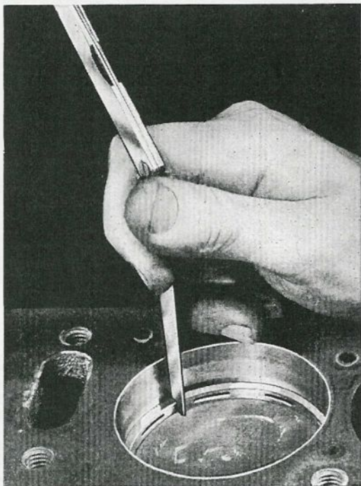
FIG. 25—PISTON RING GAP
